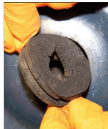
10 On récupère le caoutchouc d'étanchéité.
