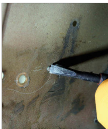
6 A l'aide d'un ciseau, on fait sauter les rivets.
