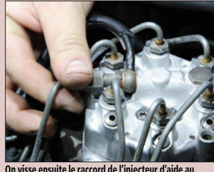
On visse ensuite le raccord de l'injecteur d'aide au démarrage à froid.
