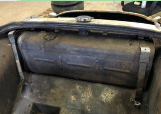
Dépose du réservoir. « Je suis obligé de disquer les vis des cerclages car tous les écrous sont soudés sous la carrosserie », précise Ghislain.
